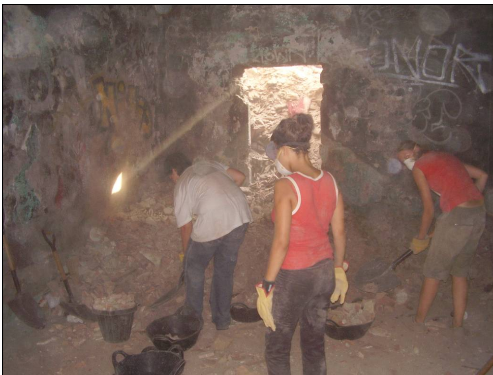
Foto 13: Treball de neteja per part dels voluntaris del pavelló de dormitori.
