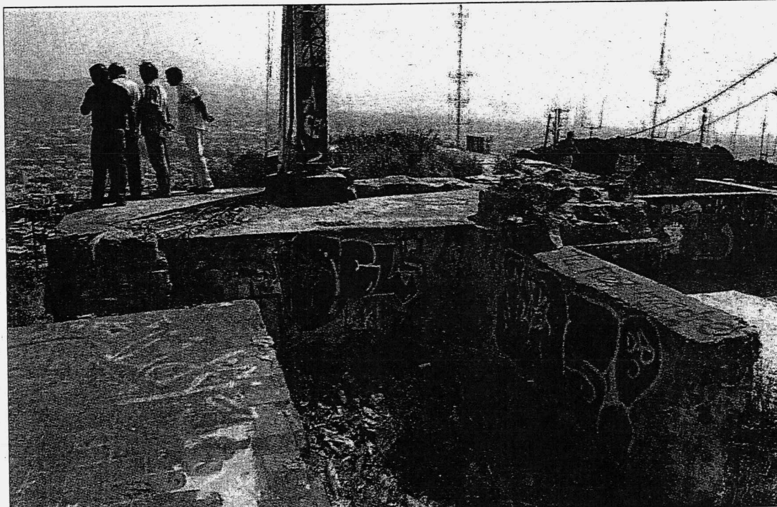
Estado de los búnkeres construidos en la Guerra Civil en el Turó de la Rovira. / GIANLUCCA BATTISTA
