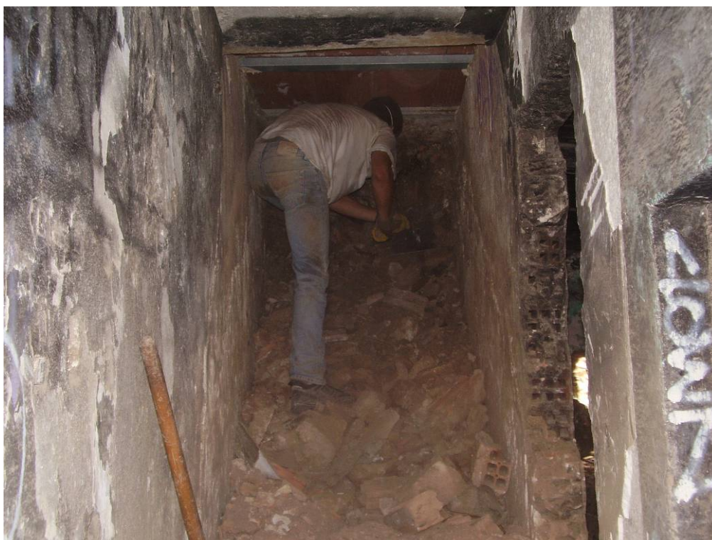
Foto 12: Treballs de neteja d'una de les portes d'accés al pavelló de dormitoris.
