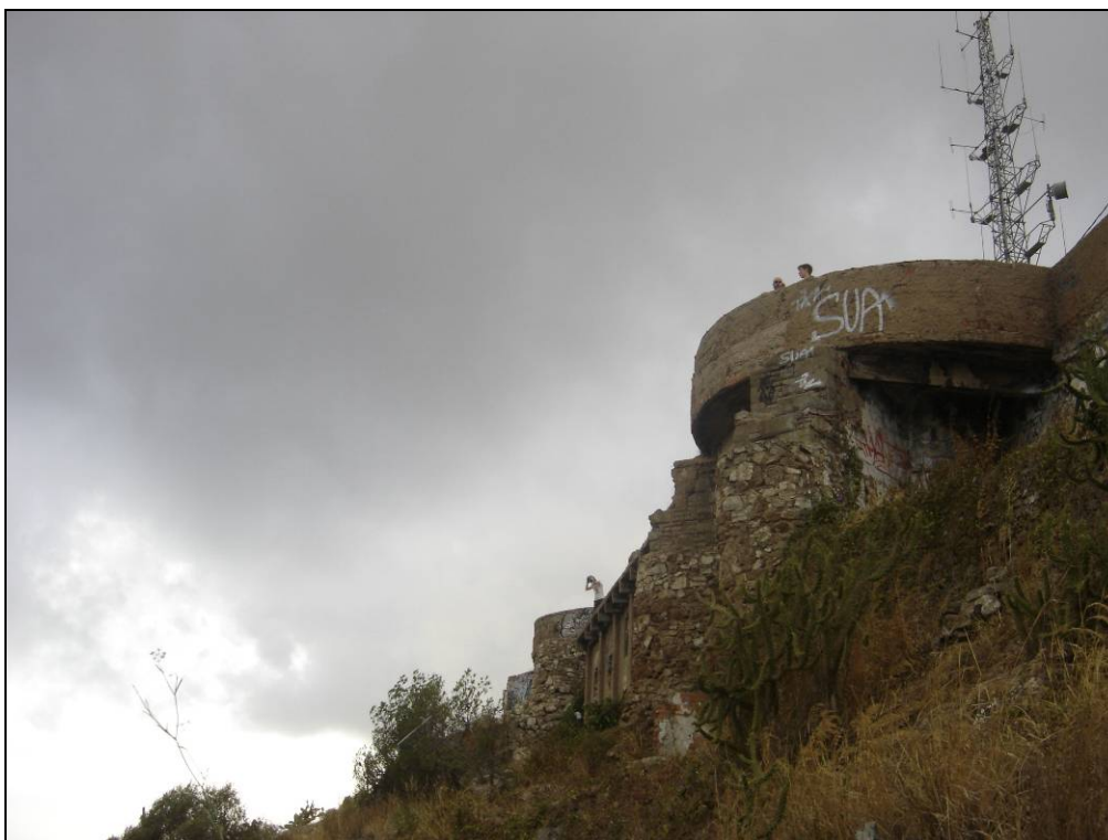
Foto 17: Vista general des del sud de les plataformes de tir.
