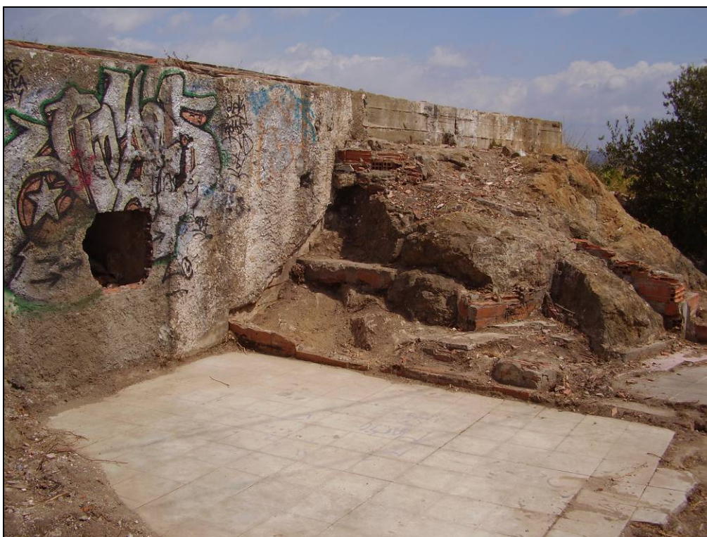
Foto 16: Porta tapiada d'accés al corredor d'unió entre dues plataformes de tir.
